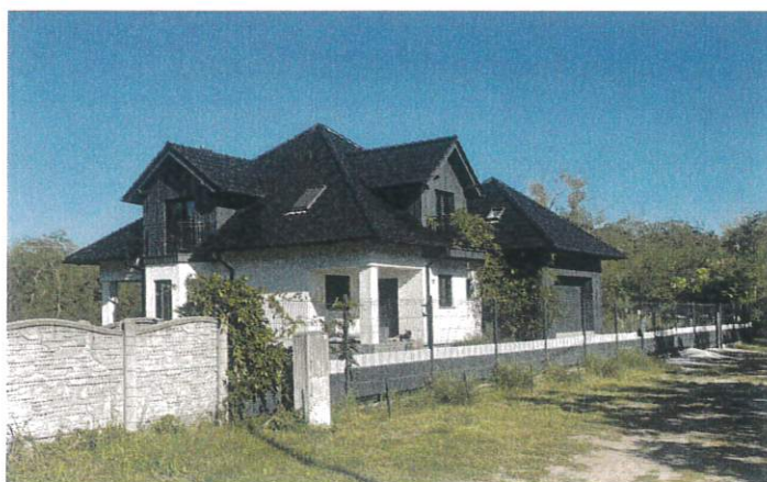
Budynek mieszkalny usytuowany na terenie działki nr 86/4 [obr. Kaleńsko]
