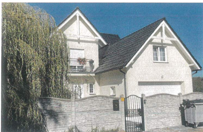
Budynek mieszkalny usytuowany na terenie działki nr 86/3 [obr. Kaleńsko]
