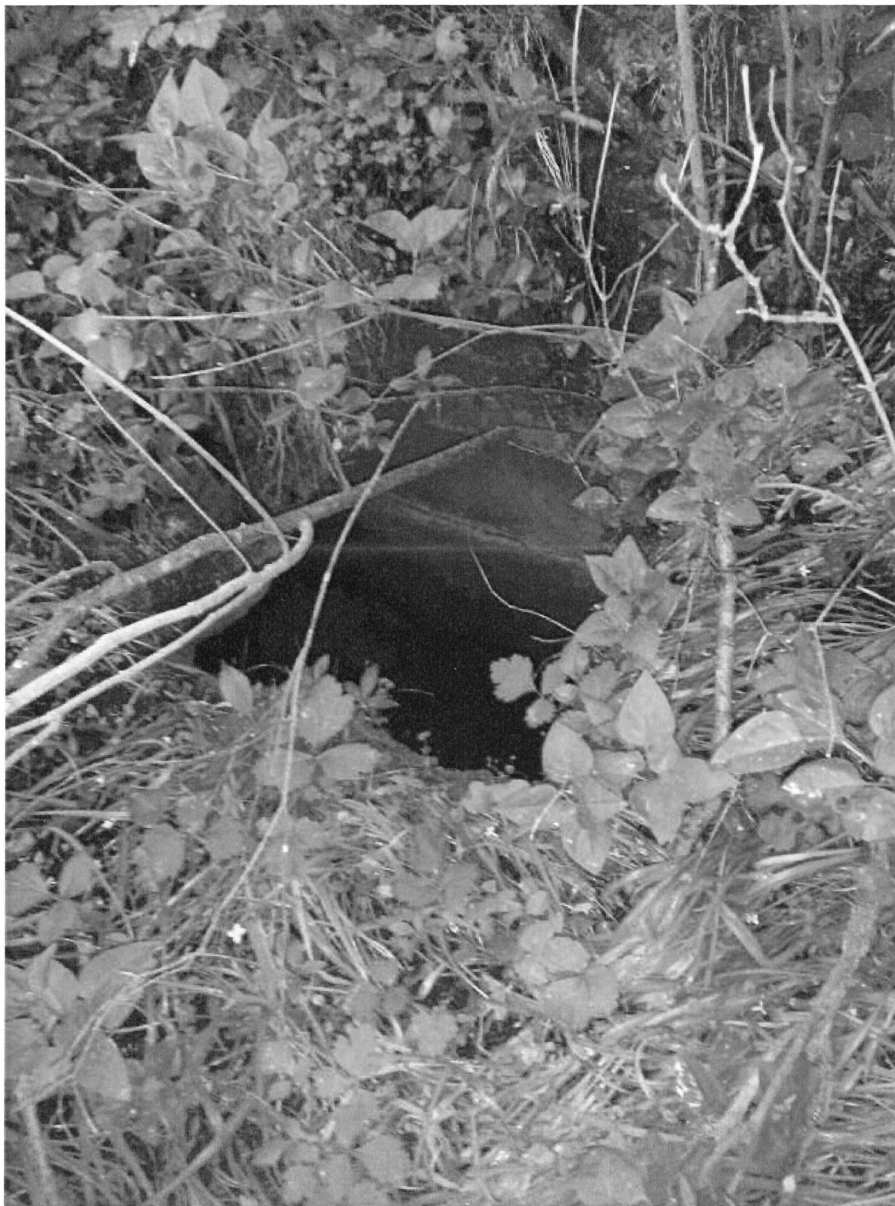
Fot. 4 Wejście do kondygnacji podziemnej budynku historycznego od strony północnej
