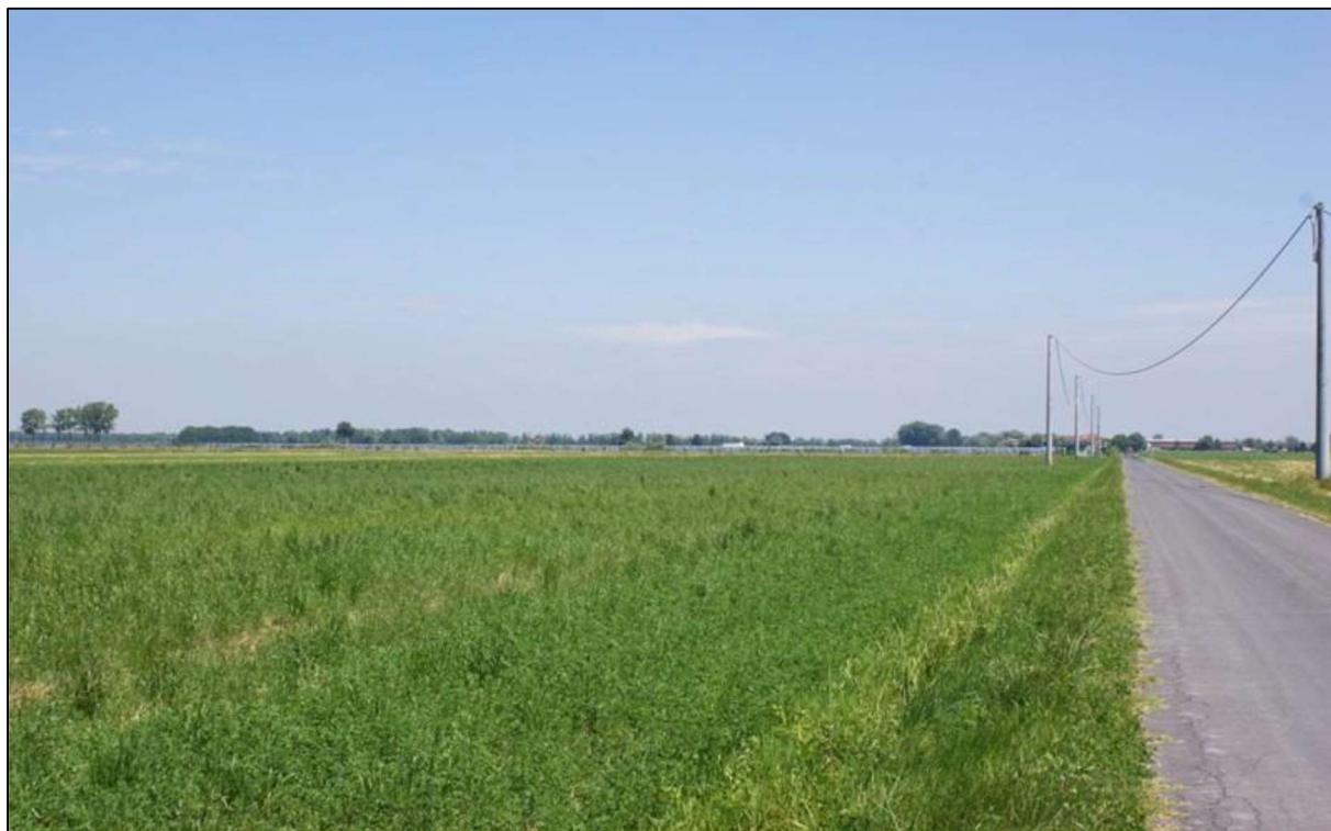
Rysunek 22 Fotografia przykładowej farmy fotowoltaicznej wykonana z odległości 500 m od niej.
