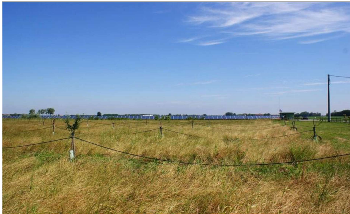
Rysunek 21 Fotografia przykładowej farmy fotowoltaicznej wykonana z odległości 100 m od niej.
