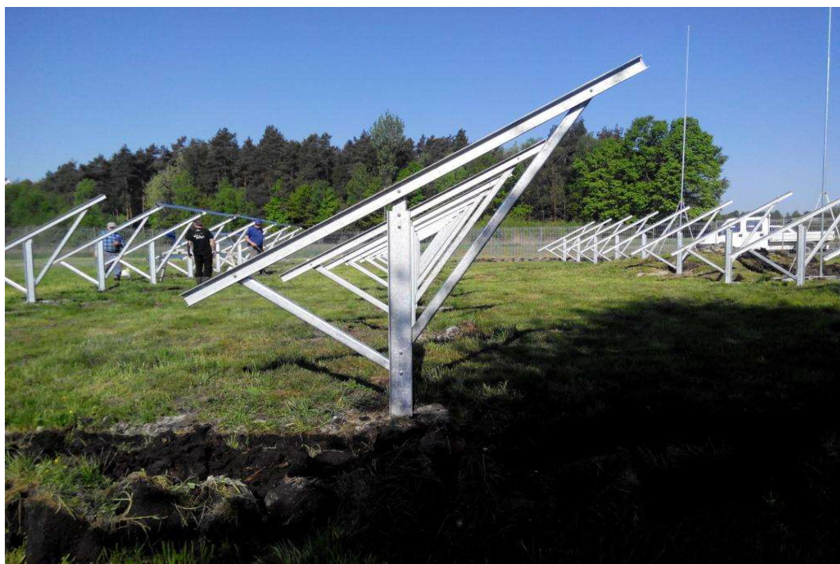
Rysunek 14 Konstrukcje wsporcze przygotowane do montażu paneli fotowoltaicznych - widoczne kilkumetrowe odstępy między rzędami.
