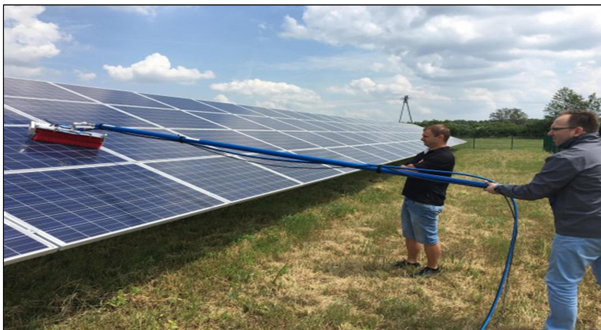
Rysunek 11. Przykładowy sposób ręcznego mycia paneli fotowoltaicznych.
