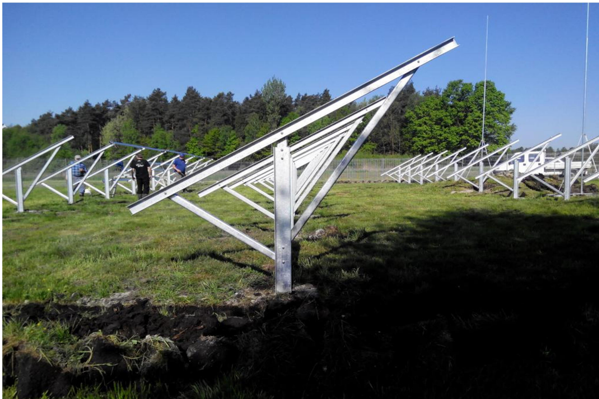
Rysunek 11. Konstrukcje wsporcze przygotowane do montażu paneli fotowoltaicznych - widoczne kilkumetrowe odstępy między rzędami.
