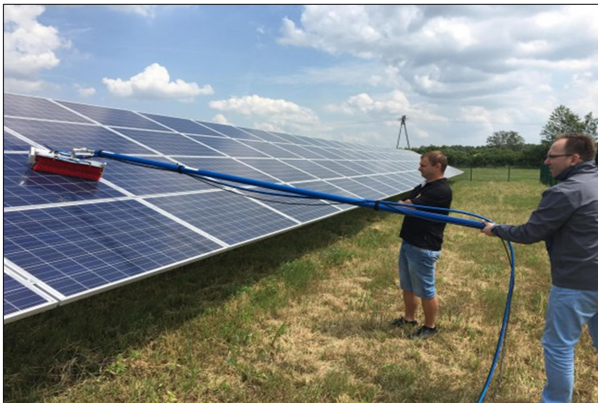
Rysunek 8. Przykładowy sposób ręcznego mycia paneli fotowoltaicznych.
