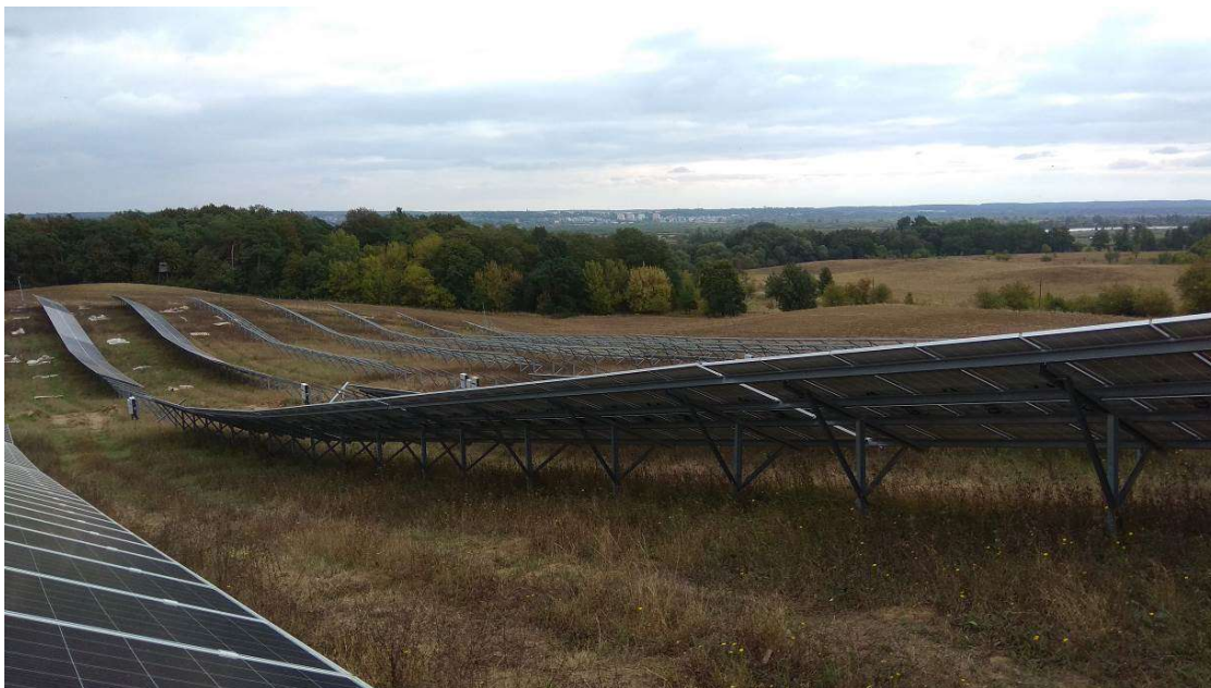
Sposób montażu modułów na konstrukcjach wsporczych.
