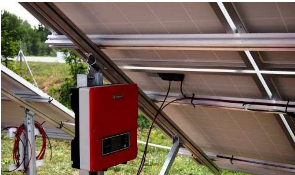
Sposób montażu falownika
