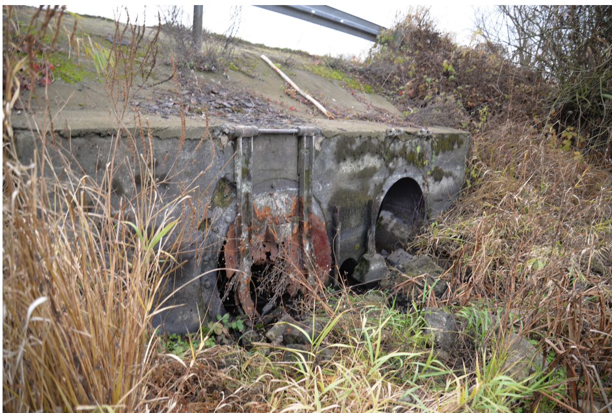
Istniejący przepust 2 * Ø 100 cm (okularowy) pod drogą wojewódzką nr 127 - wylot
