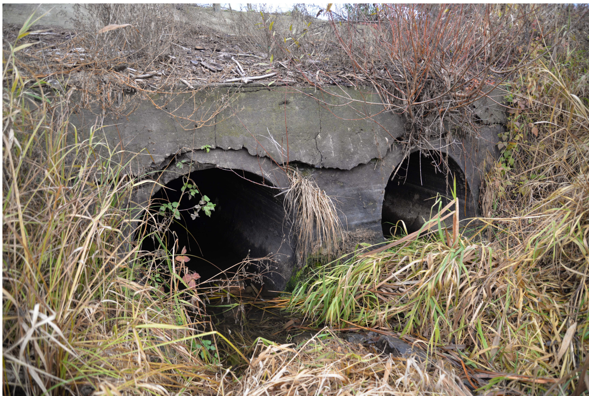
Istniejący przepust 2 * Ø 100 cm (okularowy) pod drogą wojewódzką nr 127 - wlot
