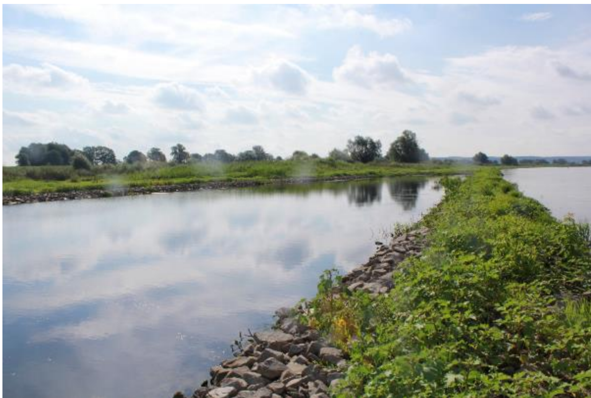
Fot. 9. Odra (stanowisko Cedynia) – tama podłużna (brzeg prawy)
