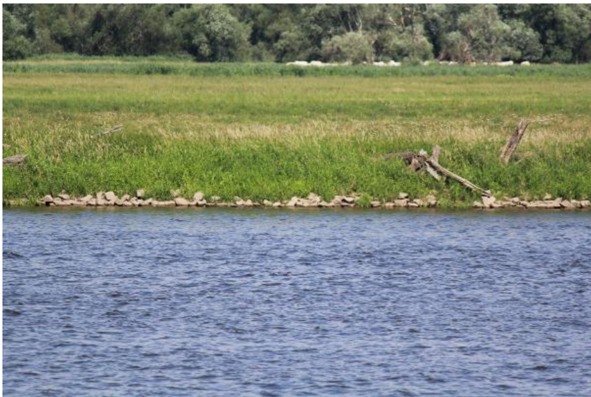
Fot. 14. Odra (stanowisko Krajnik Dolny) – umocnienia brzegowe brzeg lewy
