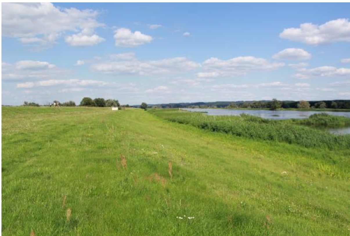
Fot. 12. Odra (stanowisko Piasek) – obwałowanie na brzegu lewym
