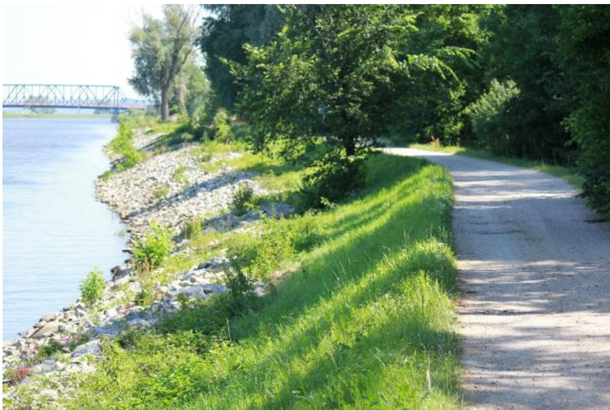
Fot. 13. Odra (stanowisko Krajnik Dolny) – umocnienia brzegowe brzeg prawy
